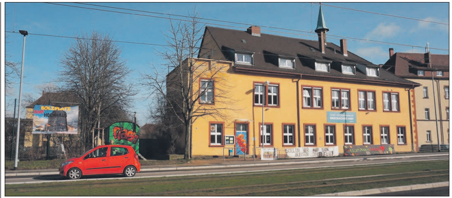
Nach jahrelangem Ringen zeichnet sich jetzt eine Lösung für das Quartier „Breisacher Hof“ ab. (Foto: A. J. Schmidt)
